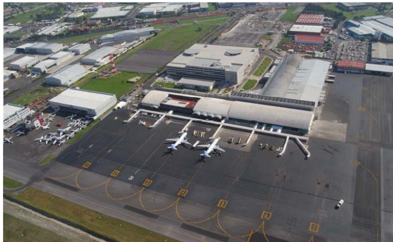
FIGURA 4.6.- PLATAFORMAS EN EL AIT.
