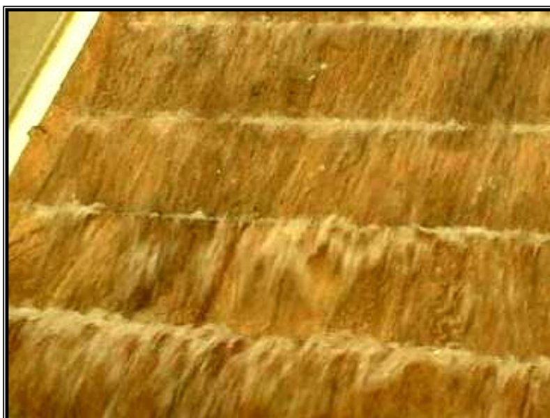
Figura 1.13.- Escalones del vertedor del Centro Comercial Plaza Universidad.
