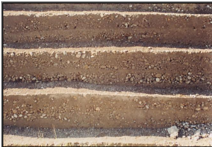
Figura 1.4.- C.C.R., en la Presa Derivadora “Las Blancas” en Tamaulipas.
