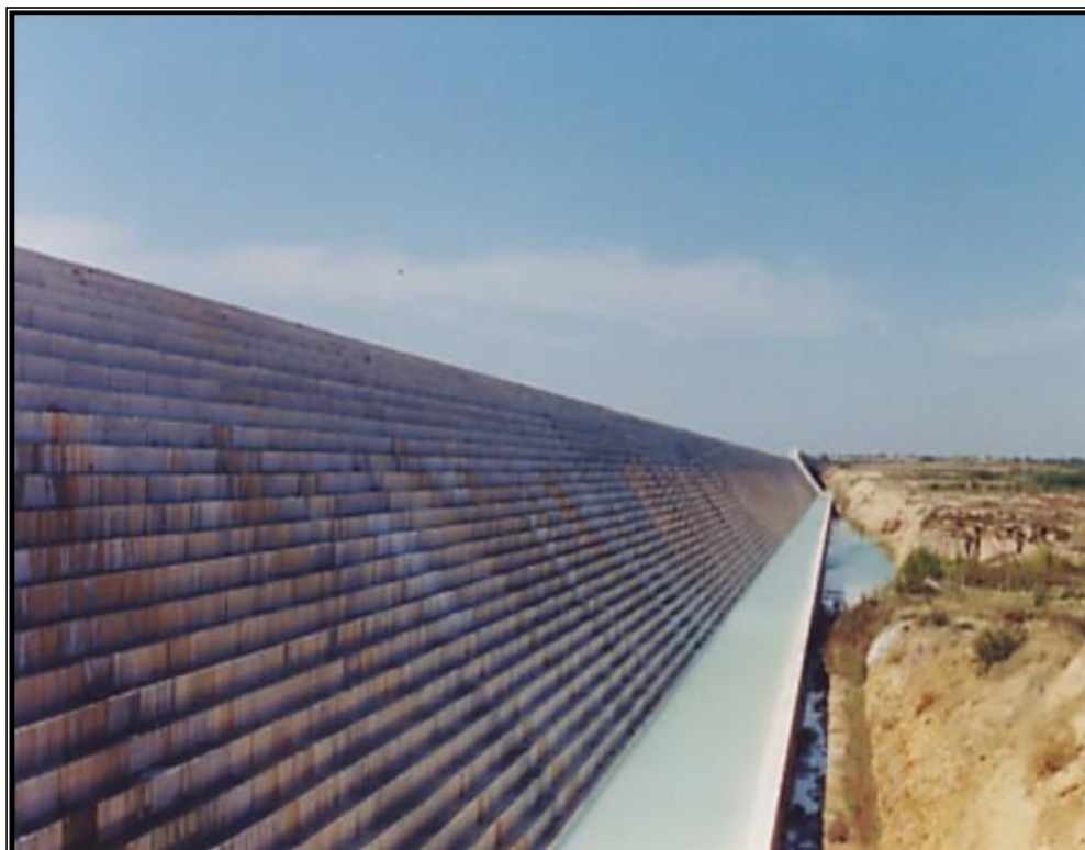
Figura 1.3.- Vertedor de la Presa Derivadora “Las Blancas” en Tamaulipas.
