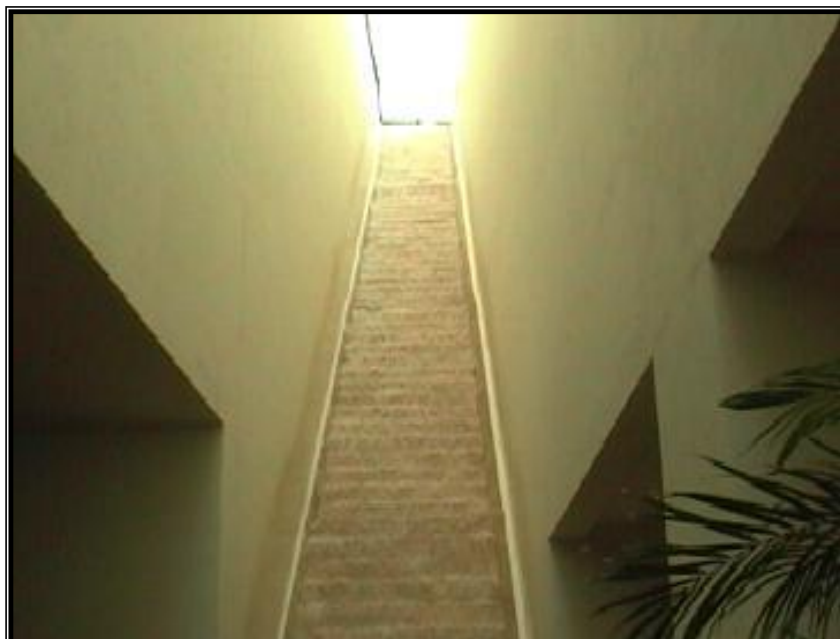
Figura 1.12.- Vertedor escalonado del Centro Comercial Plaza Universidad.
