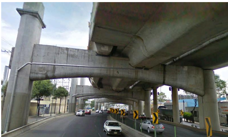
Figura 2.4. Segundo piso del periférico, D.F.
