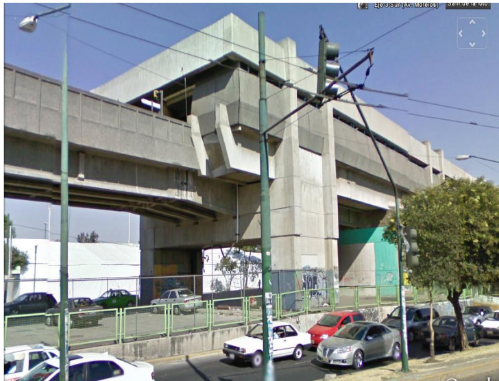
Figura 1.3. Puente tipo marco de concreto.
