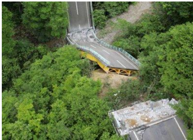
Foto 1.7. Puente en Chile foto 2010.
