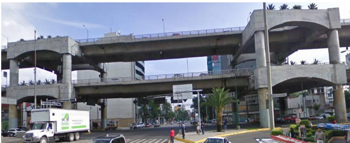
Figura 1.4. Distribuidor San Antonio
