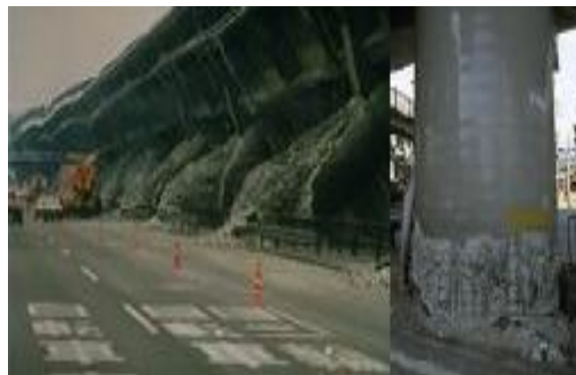
Foto 1.6. Puente colapsado en Kobe, Japón 1995.
