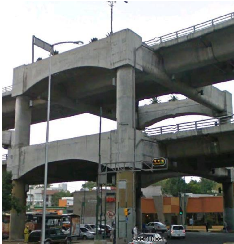
Figura 3.3. Marcos de concreto del distribuidor San Antonio.
