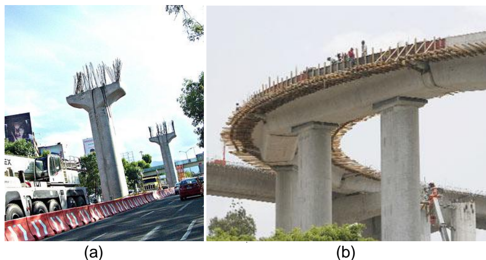
Figura 2.1. (a) Configuración tipo péndulo, (b) configuración estructural del segundo piso de periférico.
