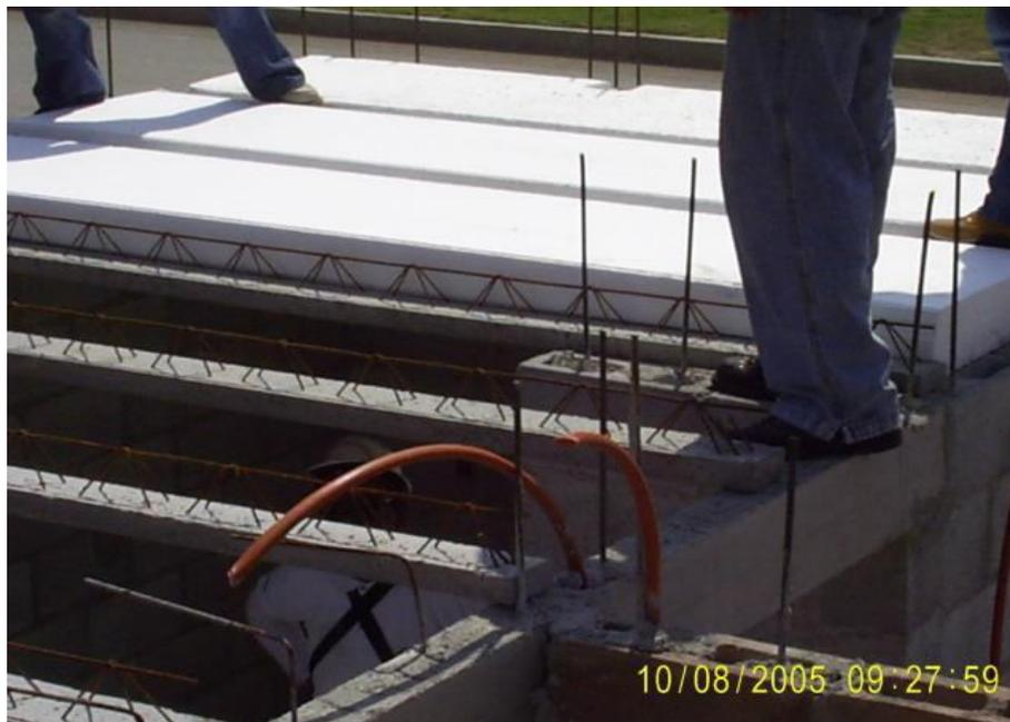
Figura No.5.8 detalle del armado de una losa con aislante termico
