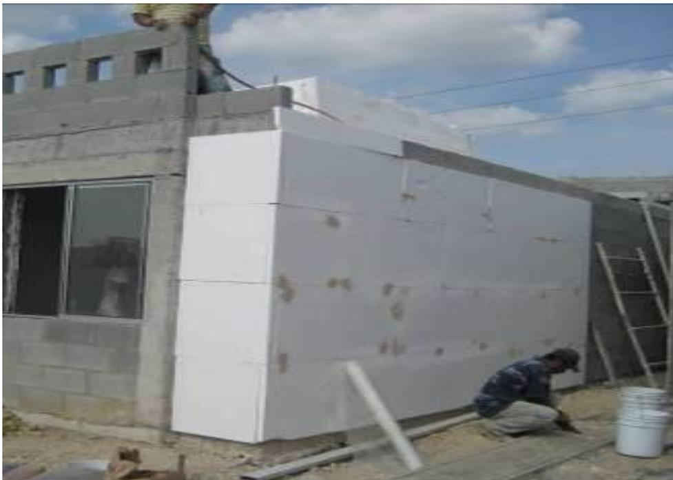
Figura 5.10 Detalle del aislante térmico en muros
