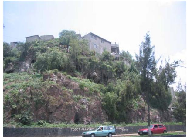
*Zona C.* Zona considerada de riesgo por inundación y agrietamiento, debido a que la explotación fue intensa sobrepasando el nivel base del terreno, afectando principalmente las construcciones, vialidades, instalaciones hidráulicas, guarniciones y banquetas.
