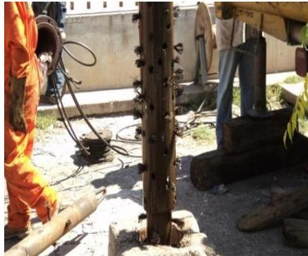
**Figura 6. Colocación de tuberías para limpieza y desazolve.**
