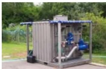
Fig. 2 Sistema de ultra filtración Huber VRM
