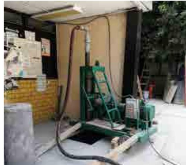
Perforación guía de 40 cm de diámetro previa al hincado, con máquina perforadora eléctrica
