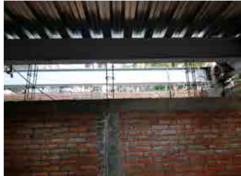
Trabajos de albañilerías en los núcleos sanitarios, elaboración de muros a base de tabique rojo recocido, cadenas de desplante y cerramiento, losas de entrepiso a base de sistema ligero –losacero-.
