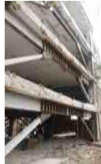
Colocación de placas y anclas de conexión entre las losas de entre piso de todos los niveles.
