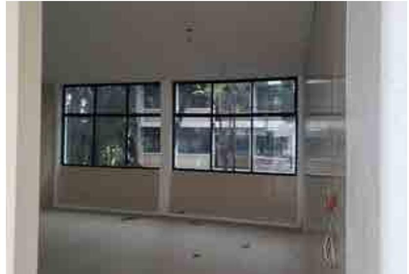
Colocación de medios muros de PVC y ventanería de recuperación en fachada poniente del edificio de aulas Ben los diferentes niveles.
