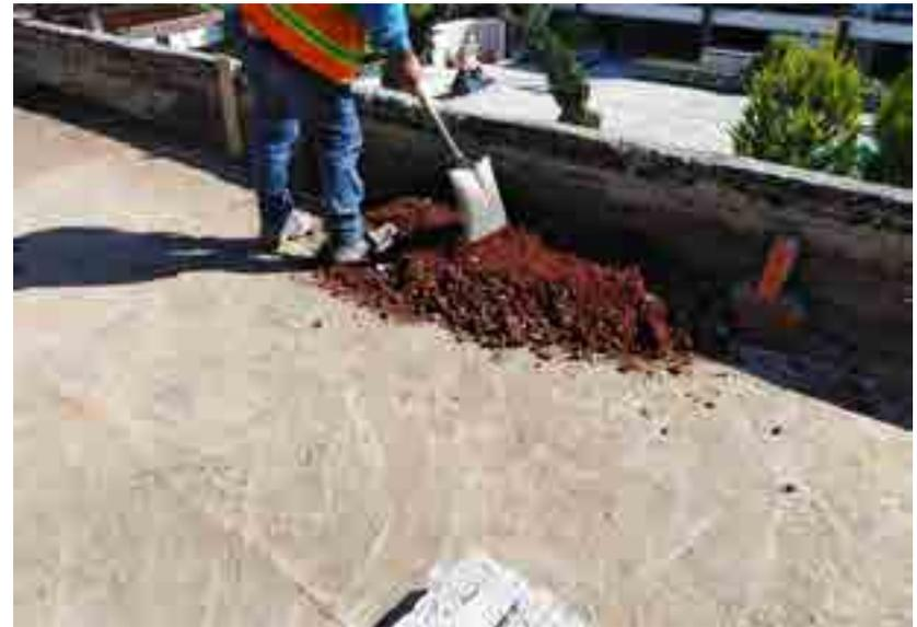
Trazo de pendientes y colocación de relleno en azotea
