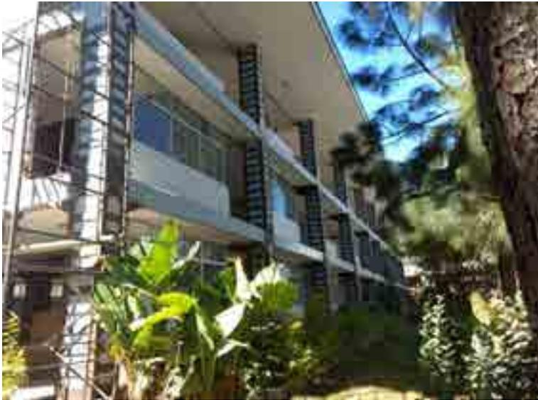
Fachada Norte Edificio "B", colocación de capiteles en nodos estructurales.
