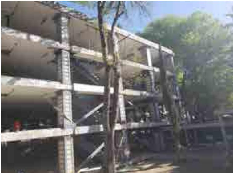
Trabajos de anclaje y montaje de escalera en P.B., 1er. y 2º. nivel del edificio.
