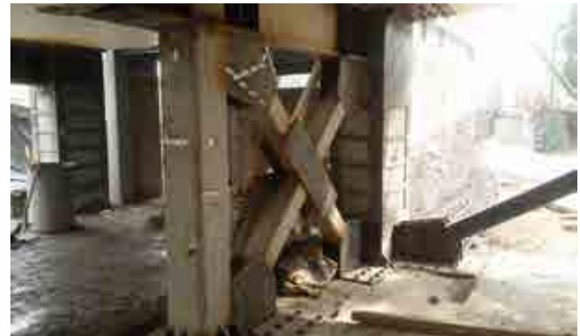
Reforzamiento tipo que se colocara en todos todas las columnas para cumplir con el proyecto de reforzamiento estructural, se observa la fachada sur del edificio.
