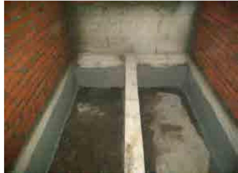
Aplicación de impermeabilizante (tipo cementoso) en Celdas de Cimentación.
