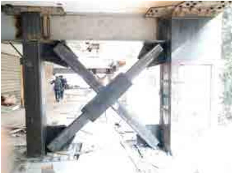
Elaboración de contraventeos en el sentido transversal del edificio a base de perfiles estructurales HSS.
