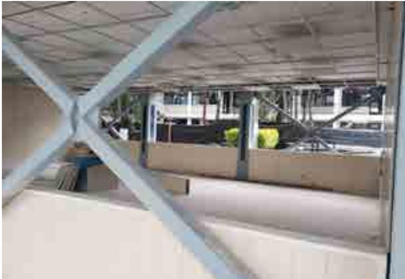
Suministro y colocación de muros de PVC en el área de reforzamiento en la planta baja del edificio B.
