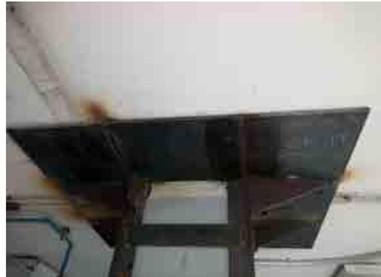
Colocación de capitel y cartabones en nodo estructural para iniciar el proceso e soldadura.
