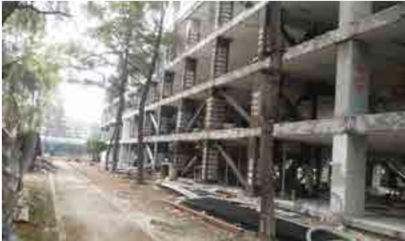
Columnas revestidas con el refuerzo metálico en fachada norte del edificio donde el avance existe en planta baja y primer nivel.
