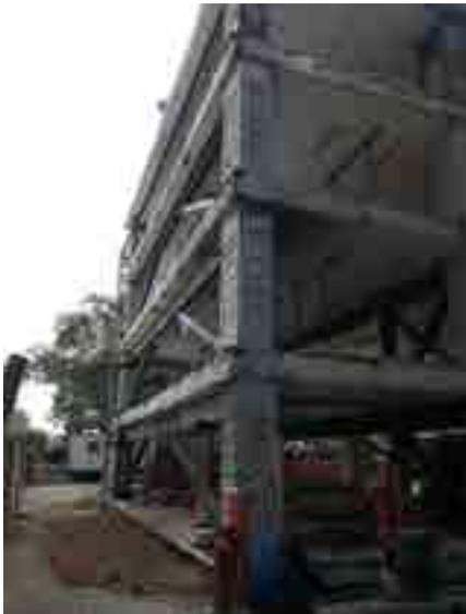
Trabajos de reestructuración en fachada oriente, colocación de contraventeos a base de perfiles estructurales HSS
