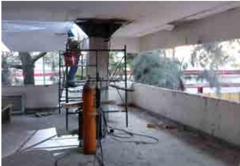
Colocación de cordones de soldadura en capitel metálico
