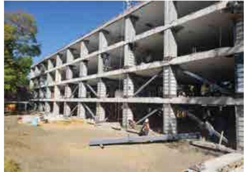
Proceso de colocación de reforzamiento de columnas, traves y contraventeos en el eje P en todos los niveles.
