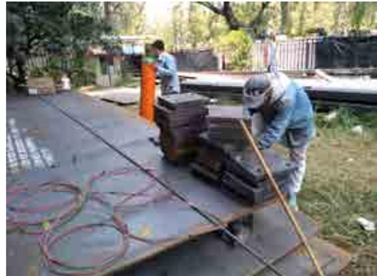
Suministro, fabricación y traslado a obra de Estructura Metálica para reforzamiento del Edificio (Placas Base).
