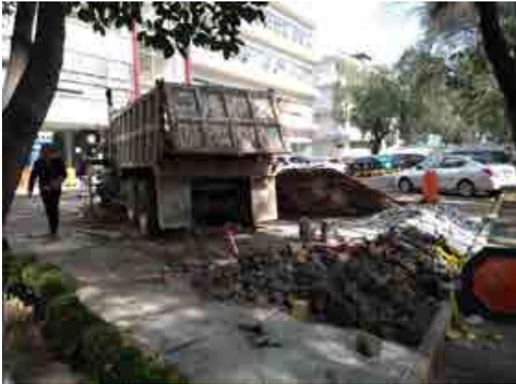
Limpeza del área de trabajo y retiro de materiales (celdas de cimentación) producto de la demolición fuera de la obra.
