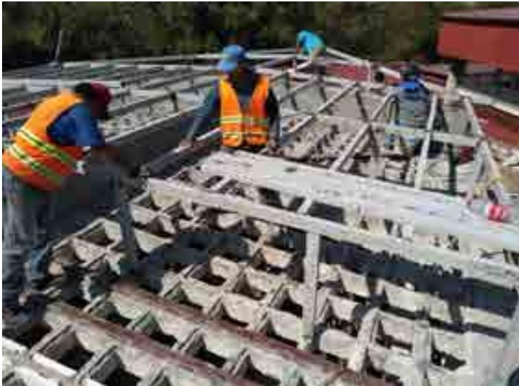
Fabricación de bastidor a base de PTR para DOMO.
