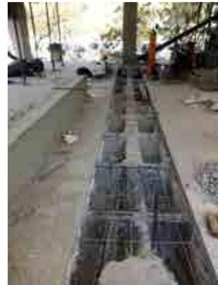
Habilitado de traveses en alojadas al interior de losas de entresuelo para sujeción de traveses metálicos sobre el lecho inferior de losas existentes.
