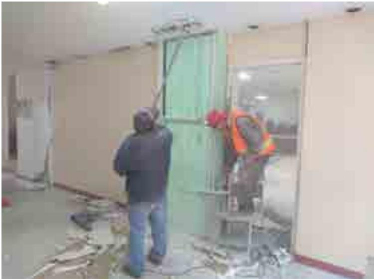
Desmantelamiento de plafón y demoliciones de muros, para liberar áreas de trabajo en Encamisado de Columnas.
