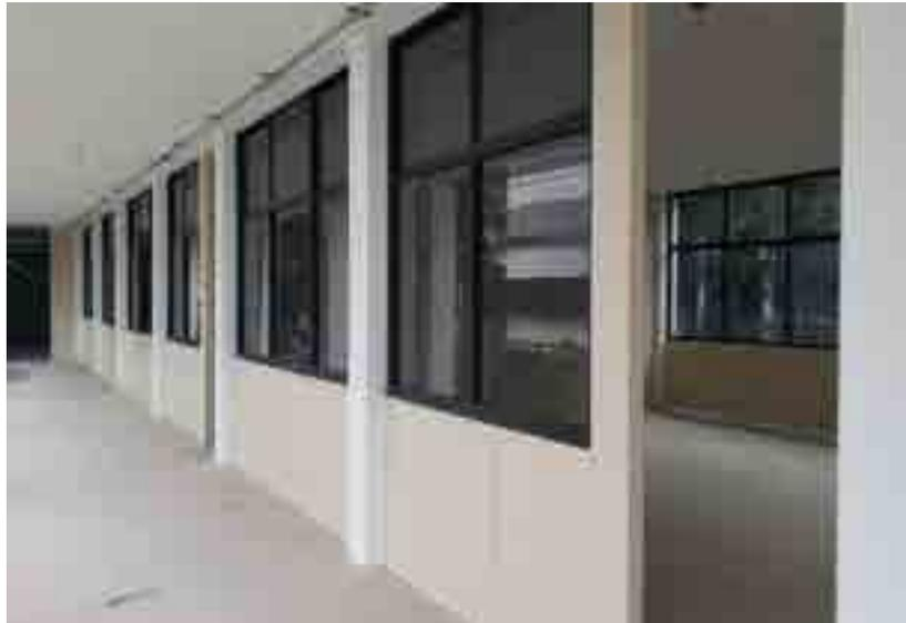
Colocación de medios muros de PVC y ventanería de aluminio nueva en pasillos y aulas en los diferentes niveles.
