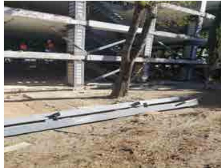
Colocación de placas y anclas de conexión en traves para fijación de escaleras entre las losas de entre piso de todos los niveles.
