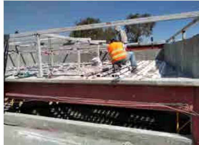
Reparación de losa nervada en DOMO.
