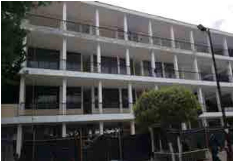
Vista de la fachada donde se muestra el avance en la colocación del muro de PVC y la cancelería nueva de aluminio.
