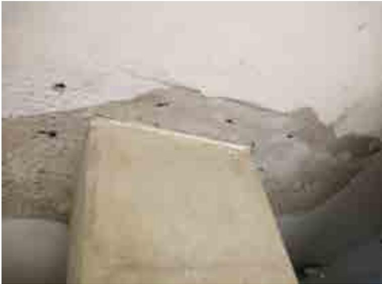
Nodo estructural en edificio "A", elaboración de barrenos para alojar anclas metálicas.
