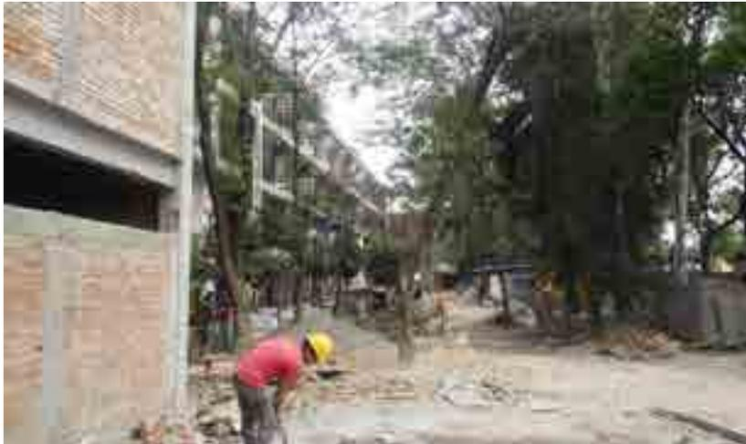
Trabajos de albañilería en dos módulos de sanitarios, se observa parcialmente el módulo oriente, ambos módulos su estructura metálica y losas están terminadas.
