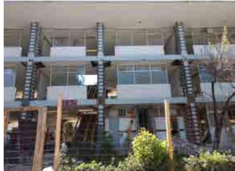
Edificio "B" fachada Norte, columnas reestructuradas al 95% en Planta Baja y Primer Nivel.
