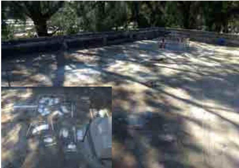
Limpeza de losa de azotea y sellado de grietas
