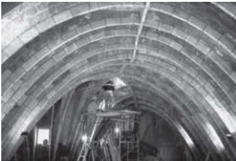
La arquería presenta numerosas variaciones en espesor, proyección horizontal y en la figura que los arcos dibujan.
