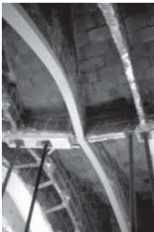
Las primeras opciones incorporaban metálicos corridos en el borde frontal.
