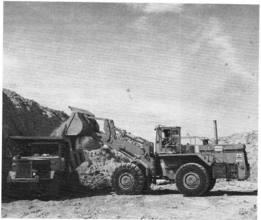
Carga, aquí se muestra la limpieza del terreno realizado por un cargador frontal sobre neumáticos terex 90 C y un euclid 20. Foto: Felipe Longoria.
