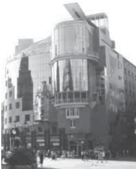
Hass Building, Viena, Austria (Hans Hollein, 1990). Fotos: Gerardo Torres Zárate
