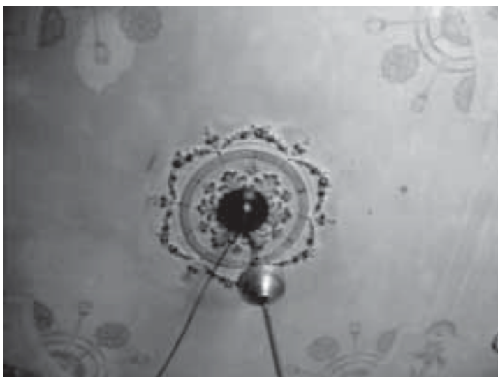
Acabados de lujo en el techo de los departamentos de Buen Tono.
