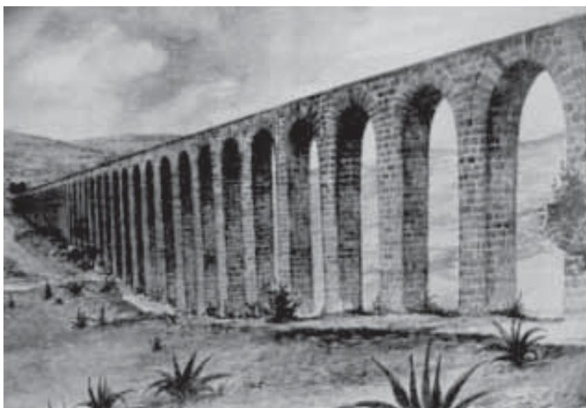
Acueducto de Los Remedios. Vivaldo Oregel Cuevas.
