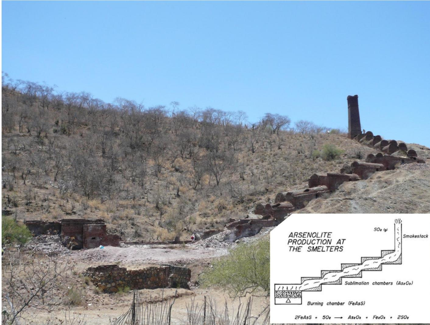
**Figura 64.** Fotografía de la chimenea de fundición de Los San Juanes en San Antonio y diagrama esquemático de la generación de arsenolita dentro de las cámaras de sublimación, tomada de Carrillo (1996)
