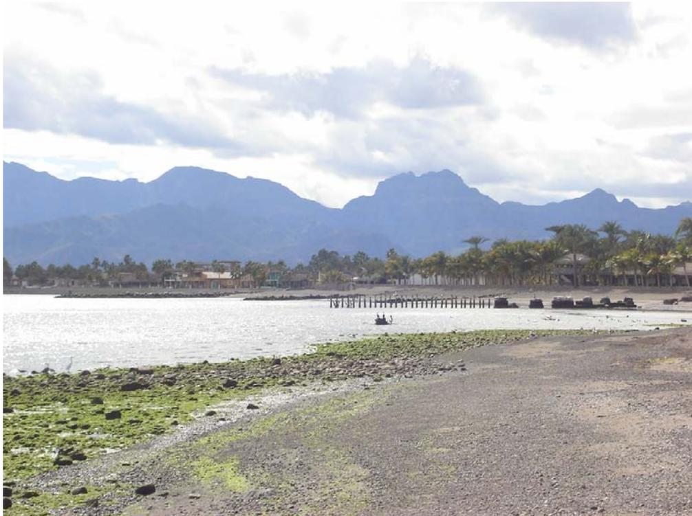
Figura 4.3.11. Rasgos morfológicos de la playa al sur del delta Las Parras. Se observa la construcción de una serie de espigones que han modificado la dinámica costera en esta zona en particular aumentando la acción del efecto erosivo sobre el de depositación.
