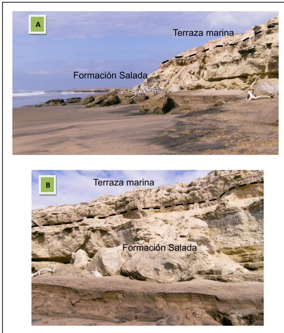
Figura 51. (A) En la Zona Norte se presentan acantilados bajos, los cuales no superan los 6 m de altura. Los acantilados están formados sobre rocas sedimentarias de la Formación Salada del Plioceno Superior y depósitos de terraza marina del Pleistoceno.
