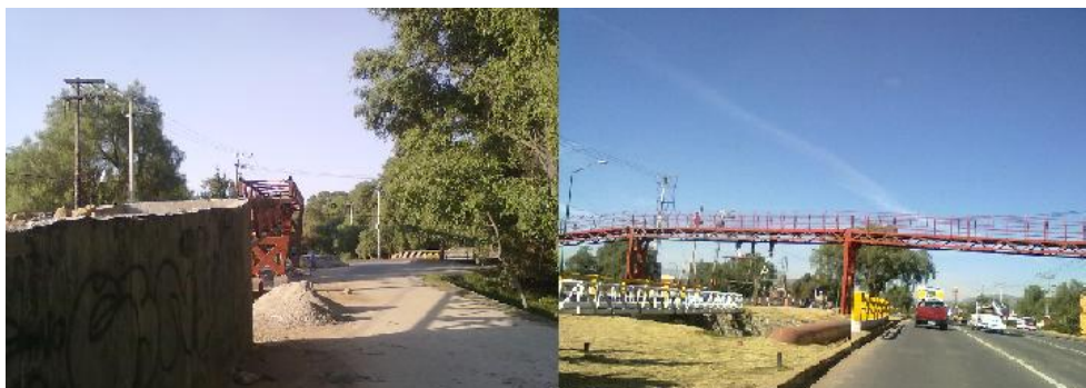
Figura 20. Puentes peatonales. FUENTE. Elaboración propia, 2012.
