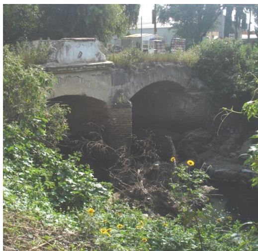
Figura 19. Puente de la Avenida San Antonio.
