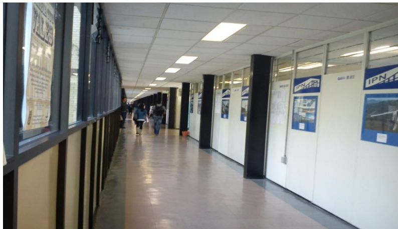
Figura 10. Acero en columnas y trabes, ESIA-UZ. Fuente: propia
