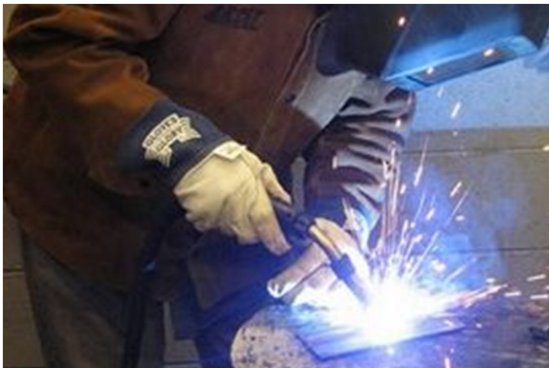
Figura VI.11.- Proceso de soldadura MIG
