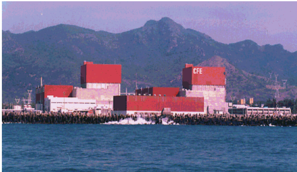
Figura 1.8. Central Nucleoeléctrica de Laguna Verde.
