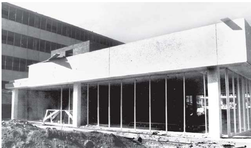
Trabajos de construcción de la ESIA Tecamachalco al inicio de la década de los 70.
