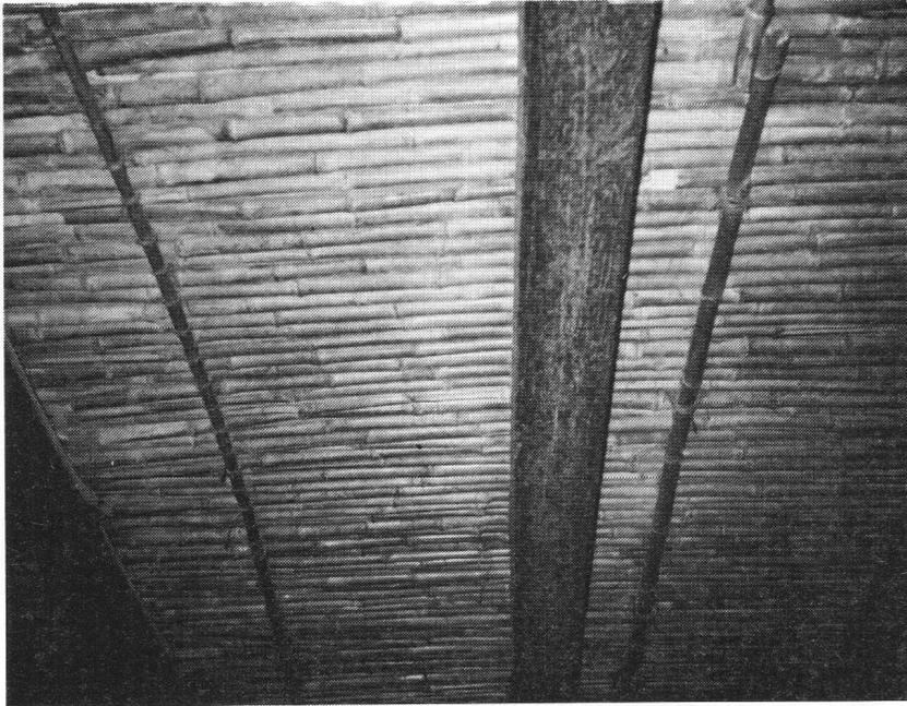
El carrizo era utilizado en cubiertas normalmente inclinadas a un agua, sujetándose éstos entre sí con una planta fibrosa muy resistente llamada "cuamecate".
