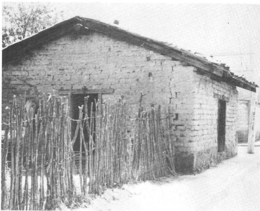
Casa de adobe en Xalatlaco, Estado de México.
