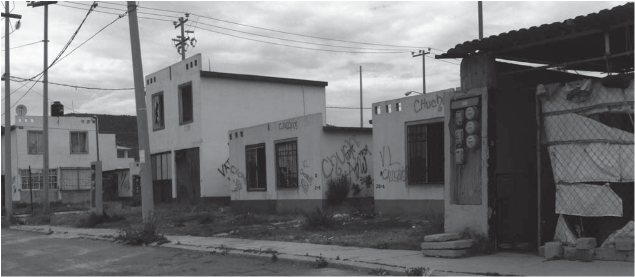
7. Viviendas abandonadas y vandalizadas, diciembre 2014.
