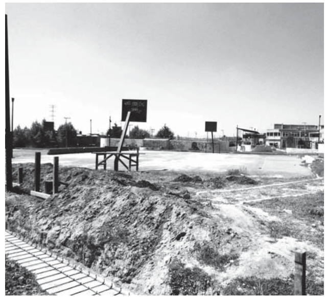
6. Estado de mantenimiento de cancha deportiva.
