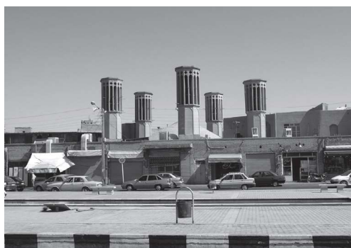
Figura 11. Fotografía de una torre de viento.
