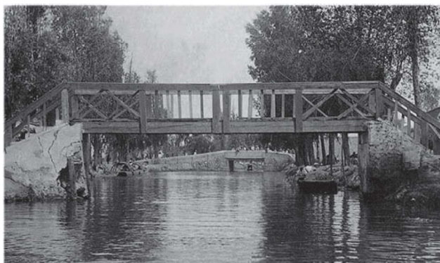
Puente en el canal de la viga.
