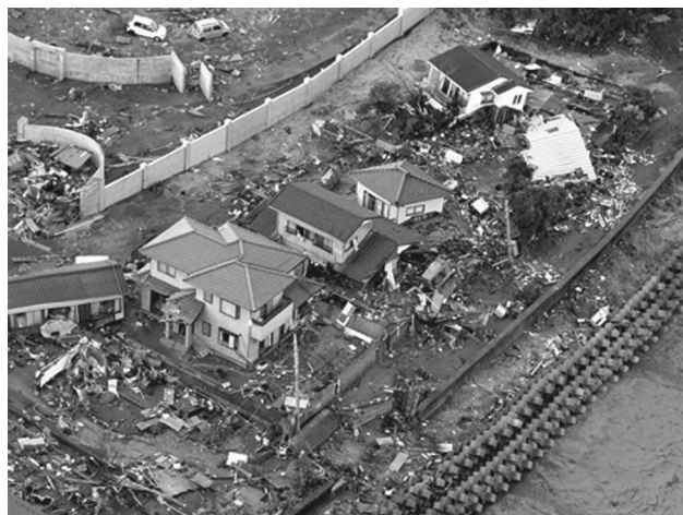
Figura 2. Las zonas de alto riesgo pueden tener daños severos en sus estructuras y hacerlas inhabitables. Fuente: www.briconsola.com , (2011).
