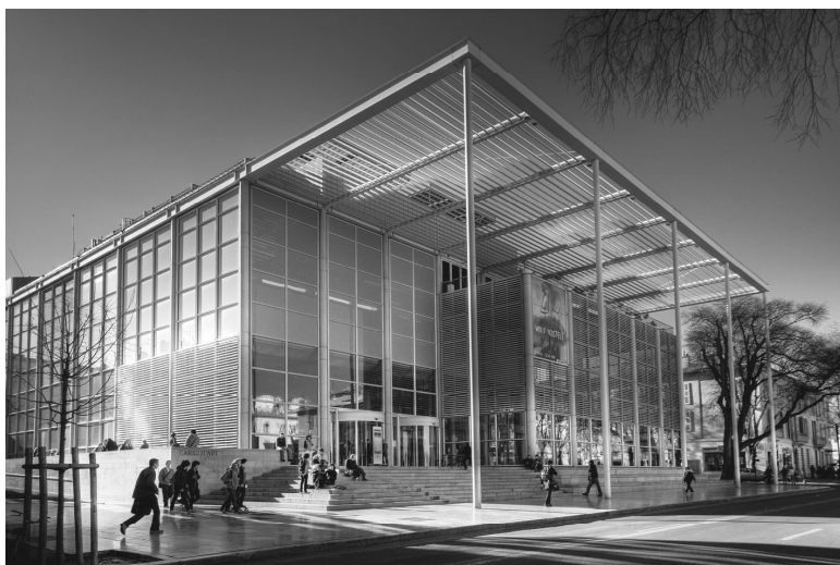
Museo de cultura de Nîmes de Norman Foster. Esta edificación tiene como adaptación bioclimática una subestructura con persianas, las cuales protegen el espacio interior de la proyección solar, dejando pasar sólo la iluminación natural. Fuente: Morales, 2009.
