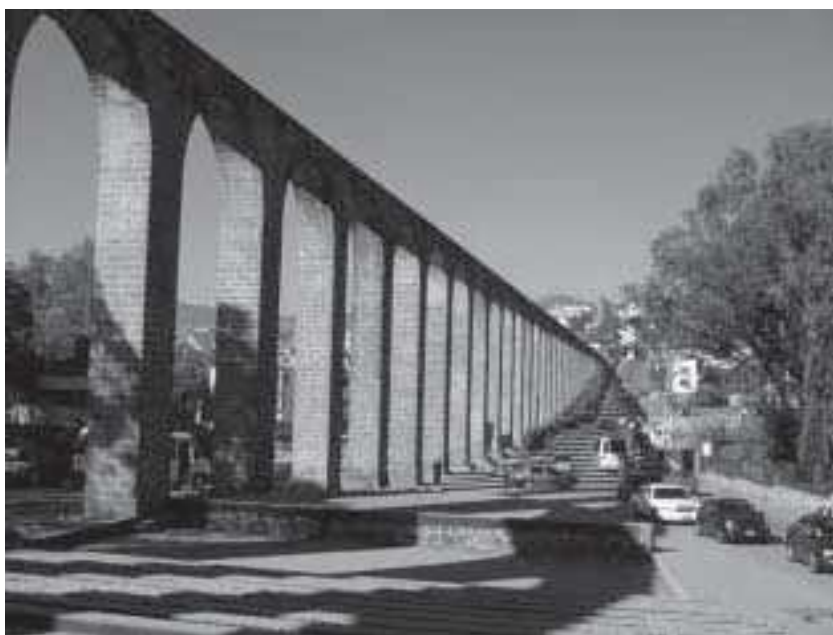
Imagen actual del acueducto. Foto: Jaime González García.
