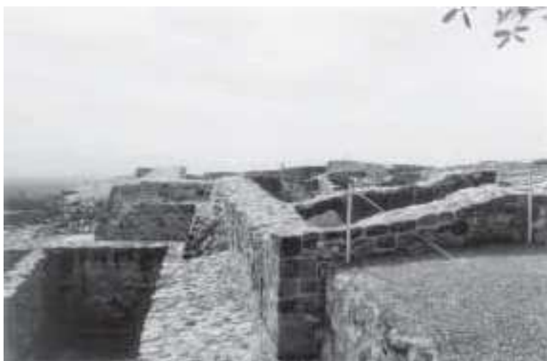
Detalle de fosas, talud y muros del conjunto arquitectónico.
