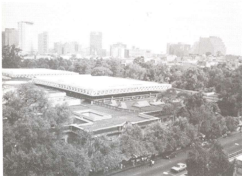
Cubierta estructural de los patios.
