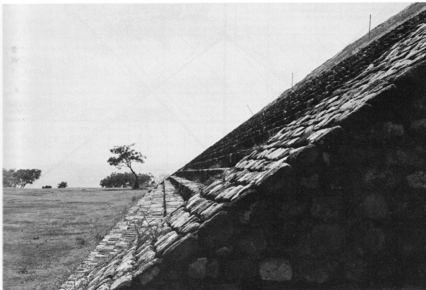
Xochicalco, Morelos. La fuerza de las líneas diagonales dominan el conjunto provocando espacios dinámicos de gran contenido estético.
