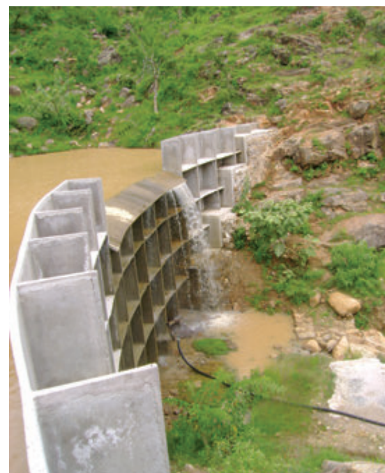
Las represas son necesarias en la mixteca, zona semiárida donde en época de estiaje baja el nivel del líquido por la infiltración y evaporación. (Foto: Cortesía CIIDIR Oaxaca)
