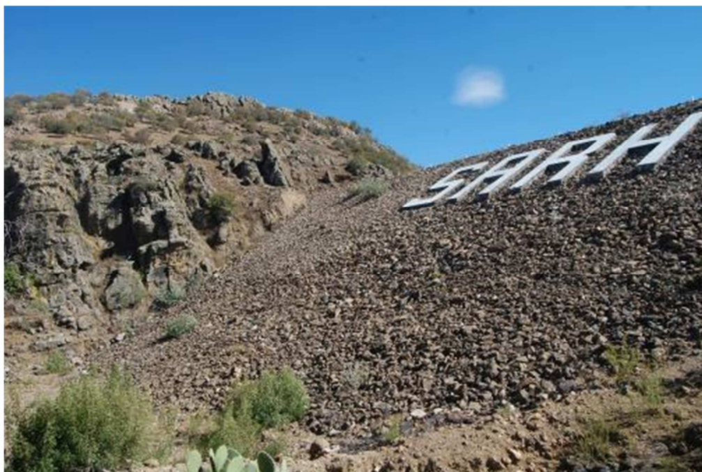
Figura 54. Cortina de la presa Tejamen
