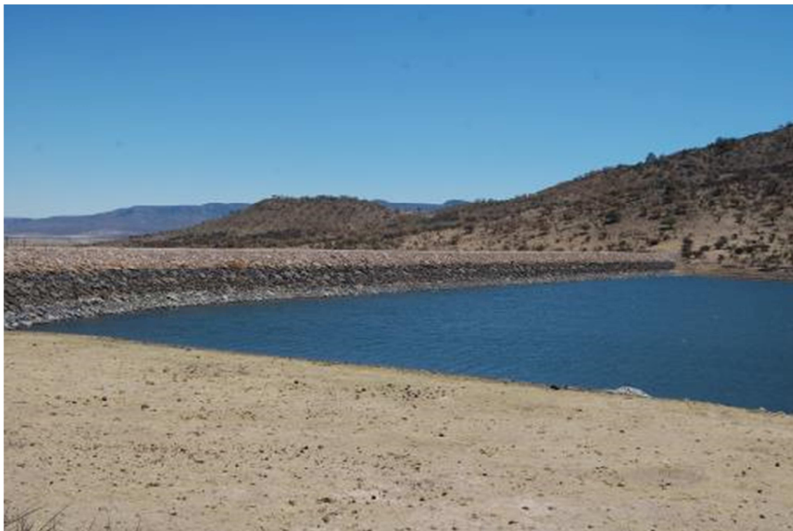
Figura 45. Cortina de la presa La Redonda
