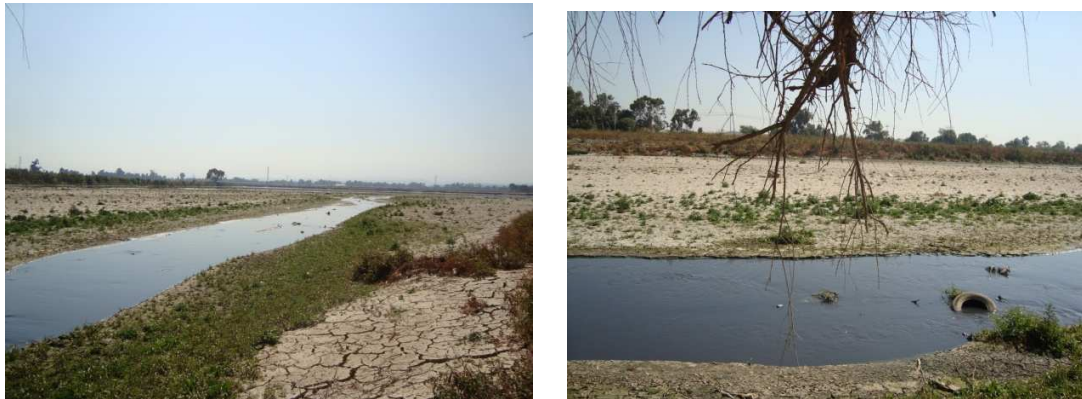
Figura 5.1 Vista panorámica del cauce del Río de los Remedios (Sitio 1)
