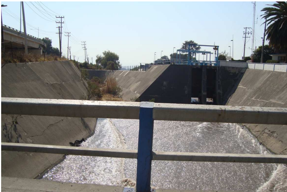
Figura 4.3 Compuertas del Vaso Regulador “El Cristo” permitiendo el flujo del agua del Río de los Remedios
