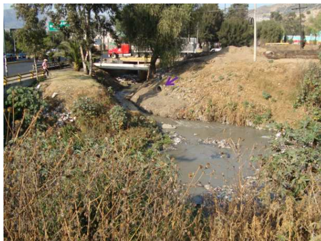
Figura 5.9 Descarga de agua residual sobre el cauce del río.
