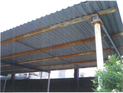
PINTURA EN MONTENES DE CARGA DE LA TECHUMBRE DE ESTACIONAMIENTO
