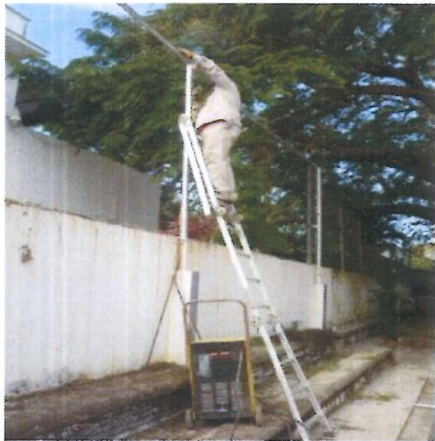
CAMBIO DE MALLA CICLÓNICA EN BARDA PERIMETRAL LADO SUR
