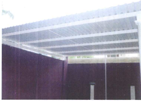
PINTURA EN MONTENES DE CARGA DE LA TECHUMBRE DE ESTACIONAMIENTO
