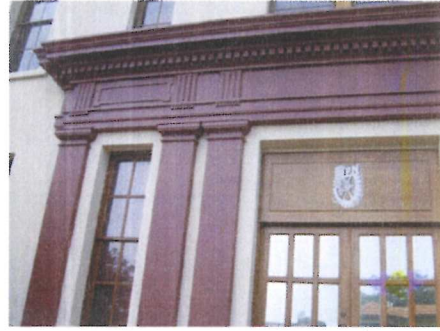
PINTURA DE LA FACHADA DEL EDIFICIO
