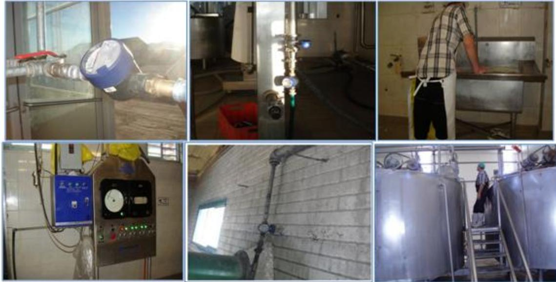
**Figura 23. Ubicación de los medidores de flujo para agua y tinas doble "O".**
