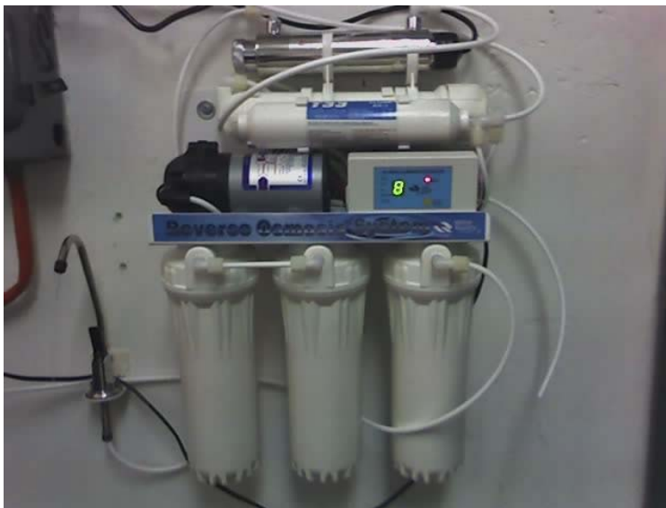
Figura 43. Sistema de ósmosis inversa para el tratamiento de agua para bebida.
