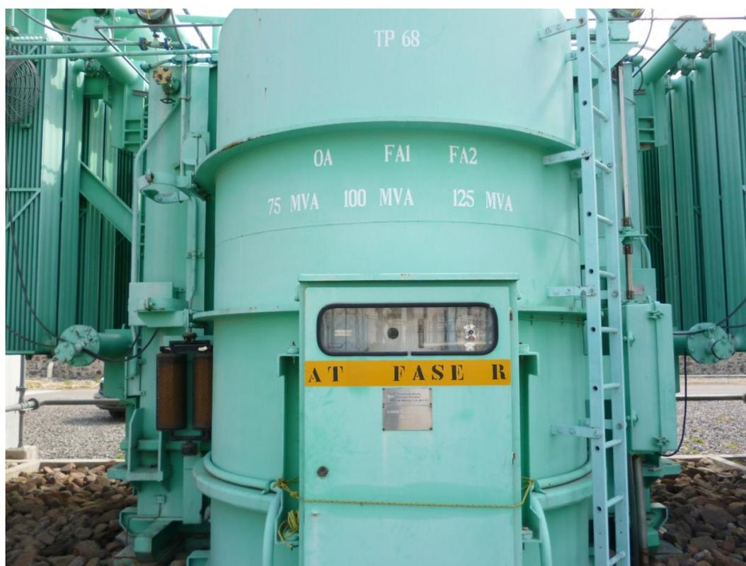
Figura No.70. Transformador reductor de 400 a 230 kV.
