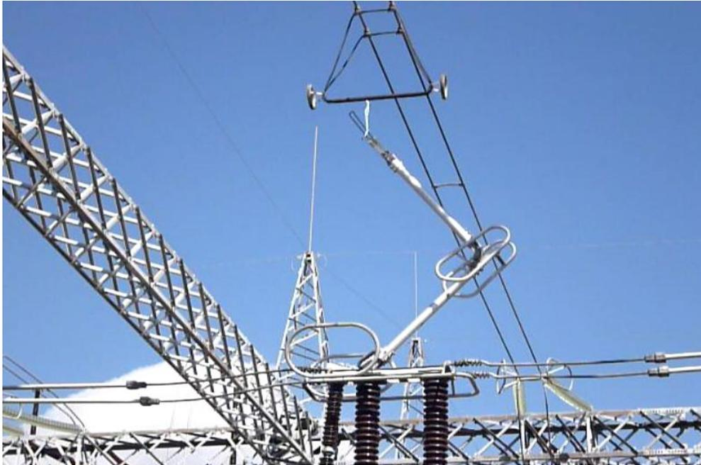
**Figura No. 55.** Cierre de cuchillas A3462 bus 2 fase A
