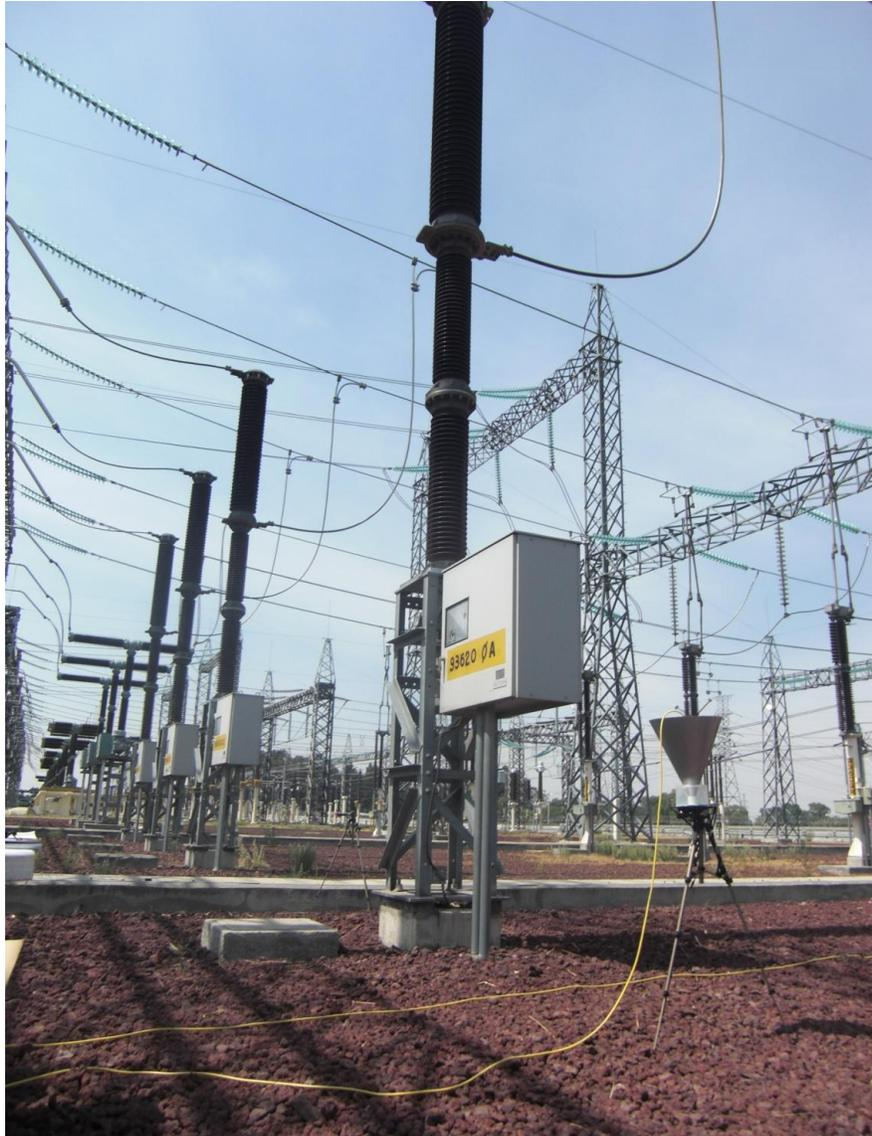
**Figura No. 19.** Fotografía del Interruptor de Potencia de 230 kV.
