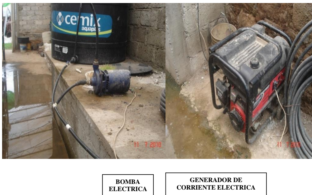
Figura 4.24 Instalación de la bomba y el generador de corriente eléctrica (Fuente propia)
