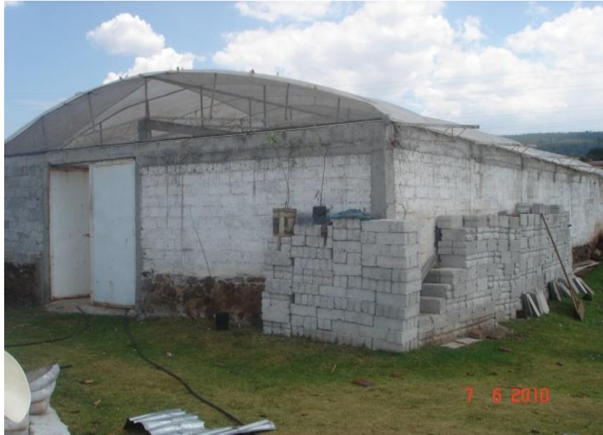
Figura 4.3. Vista frontal del invernadero (Fuente Propia)
