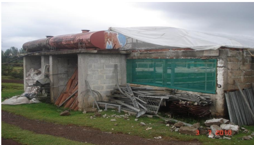
Figura 4.5 Vista posterior del invernadero (Fuente propia)
