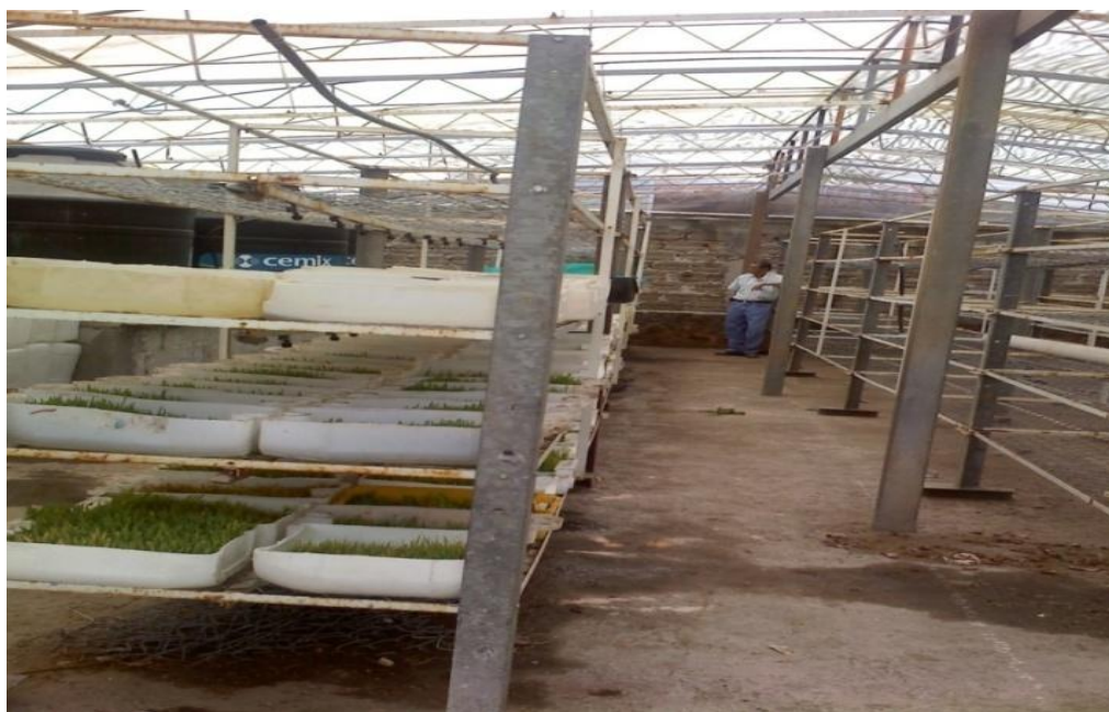
Figura 4.8. Espesor del piso de concreto del invernadero (Fuente propia)
