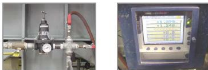
Fig.7.19 Evaluación de la presión. (a) Control de presión en las cámaras, (b) registro de presiones durante la prueba
