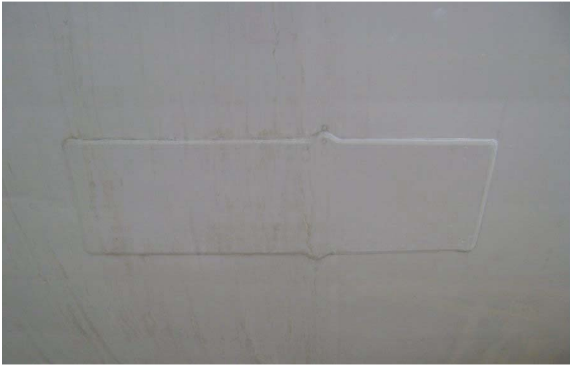
Figura 2. Reparación realizada, localizada entre las estaciones 1090RH-1070RH del fuselaje.
