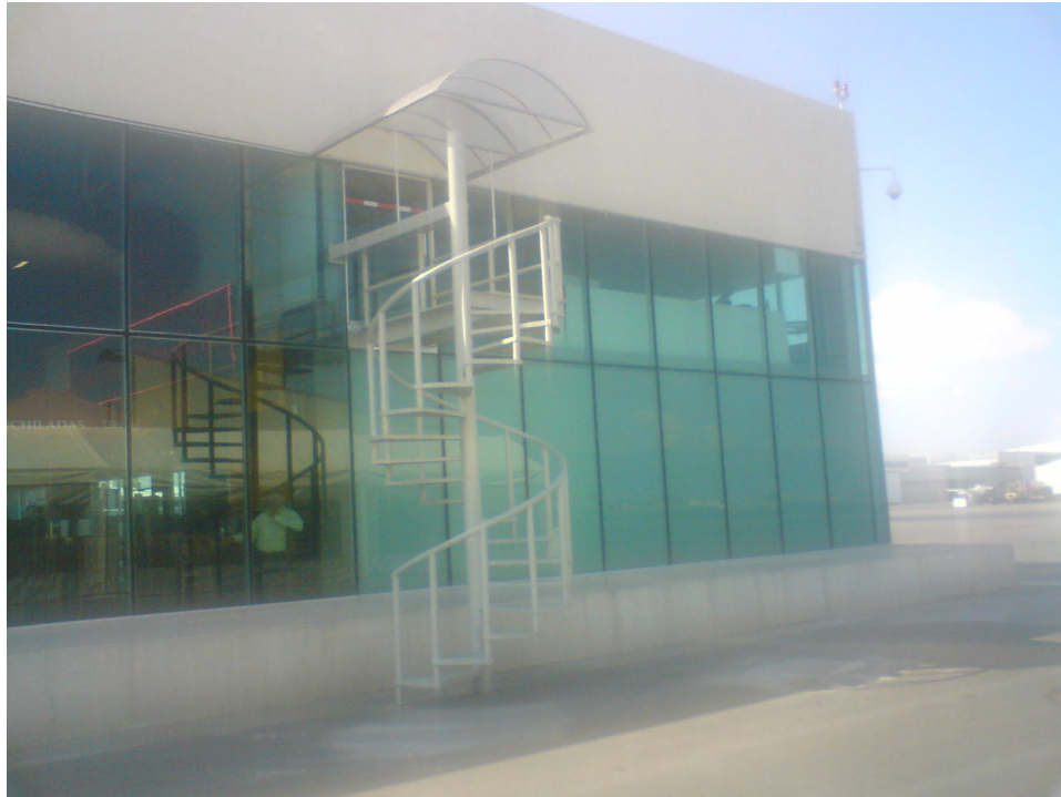
Figura 5.4.1.- CCO del Aeropuerto Internacional de Toluca
