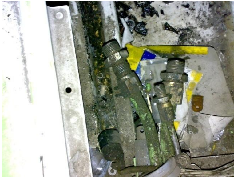
Imagen No. 21 - Líneas hidráulicas
