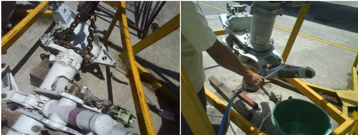
Imagen No. 28 - Mantenimiento del cilindro exterior
