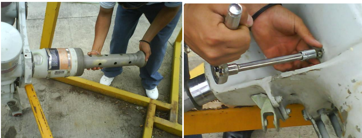
Imagen No. 32 - Instalación del tubo de orificios
