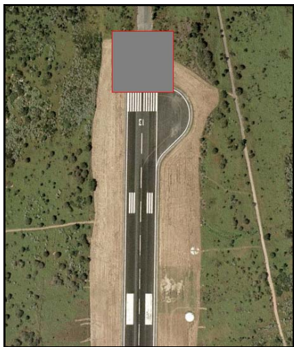
Figura No. 52 “Cabecera 13 del Aeropuerto de Reynosa”
