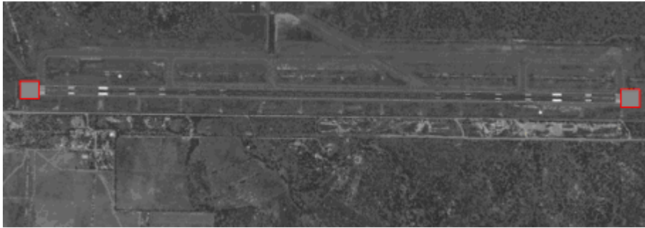
Figura No. 35 "Pista principal del Aeropuerto de Durango"
