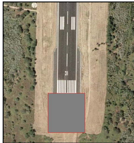
Figura No. 53 “Cabecera 31 del Aeropuerto de Reynosa”
