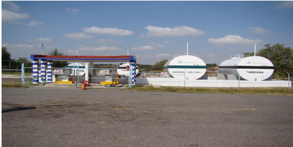
Figura N°5 Planta de Combustible
