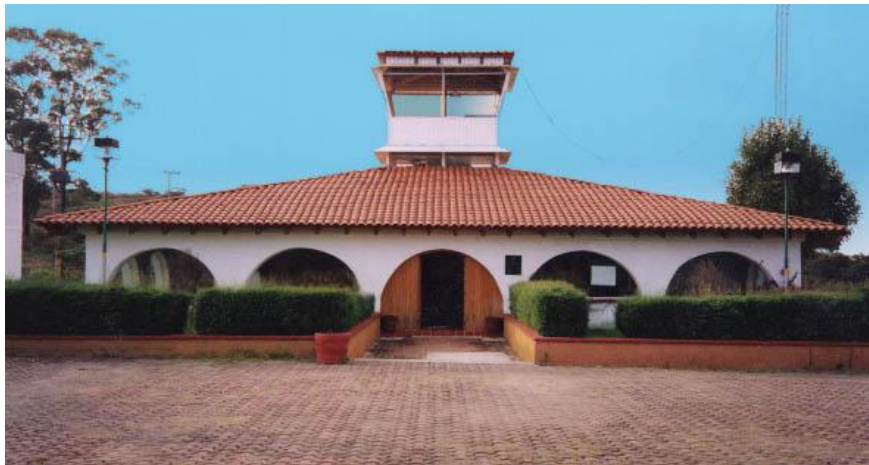
Figura N°3 Edificio terminal y torre de control
