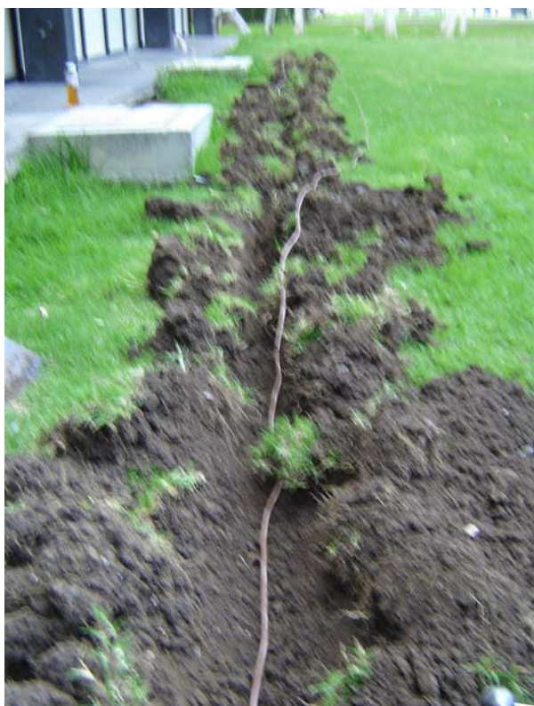
Fig. 2.4.- Tendido de las líneas para cada electrodo.
