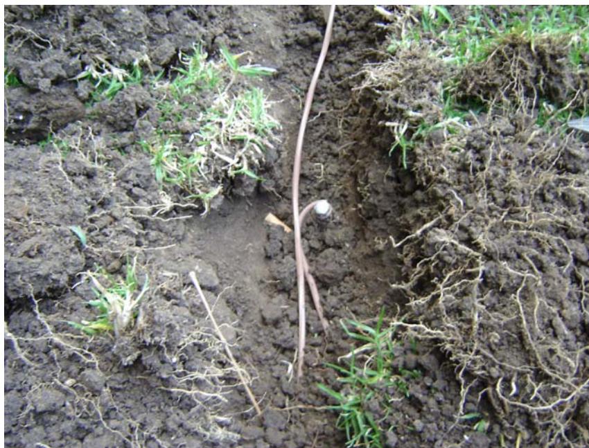
Fig. 2.3.- Forma como se enterraron los electrodos.
