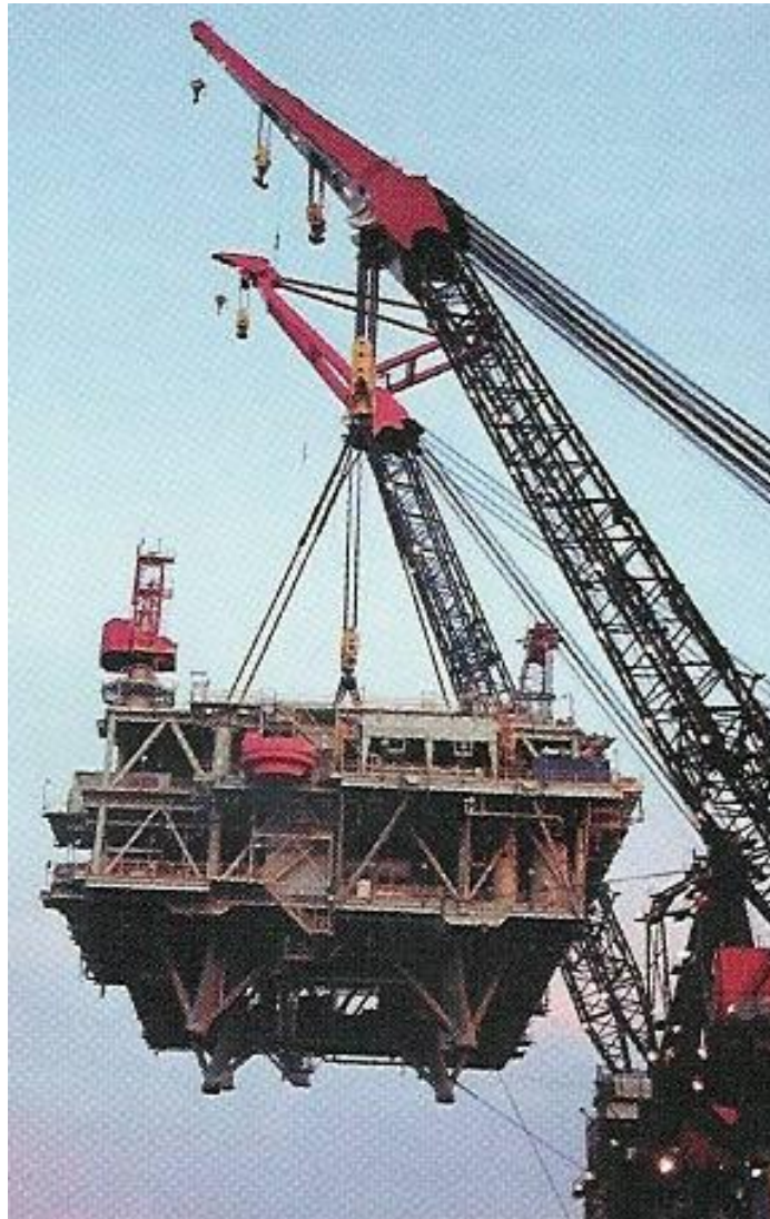
Fig. 1.6 Colocación del deck
