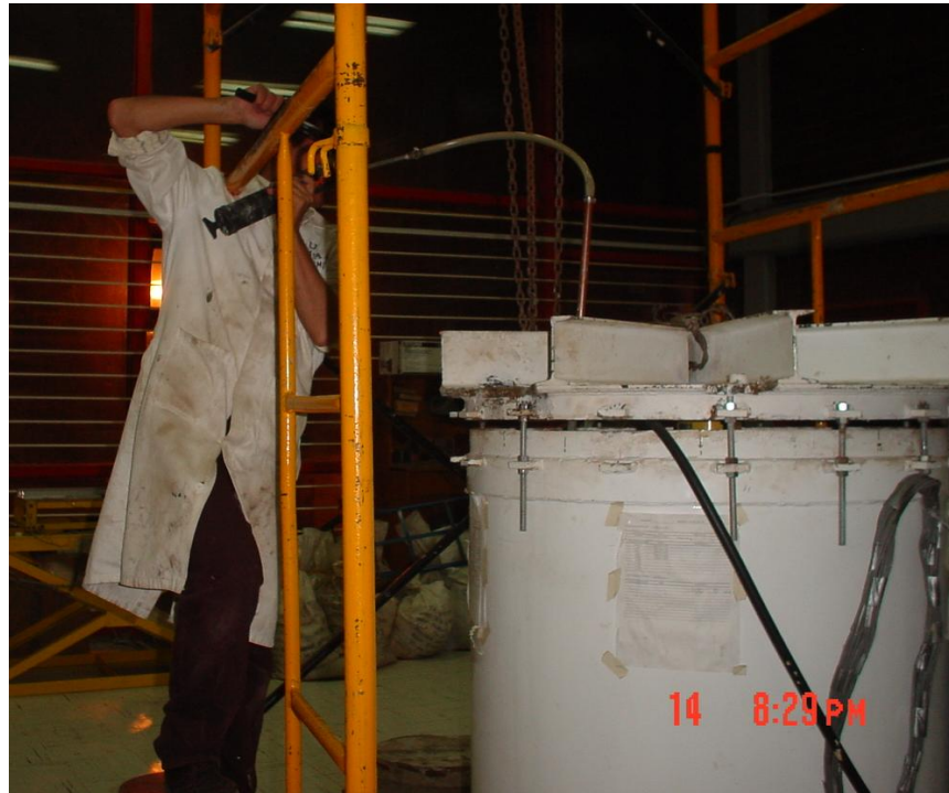
Fig. 3.22 Inyección de la mezcla en el hueco.
