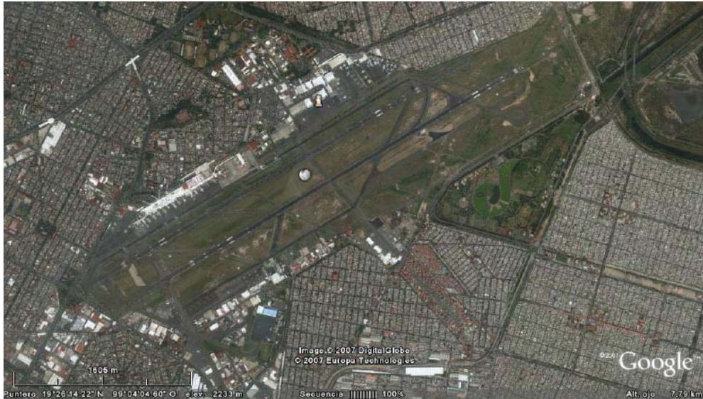
Fig. 1.1 Aeropuerto Internacional de la Ciudad de México (AICM)
