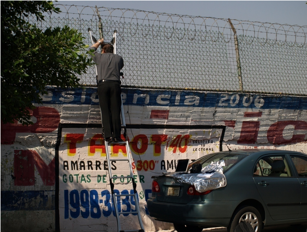
Fig. 6.4 Sistema de medición instalado en sitio
