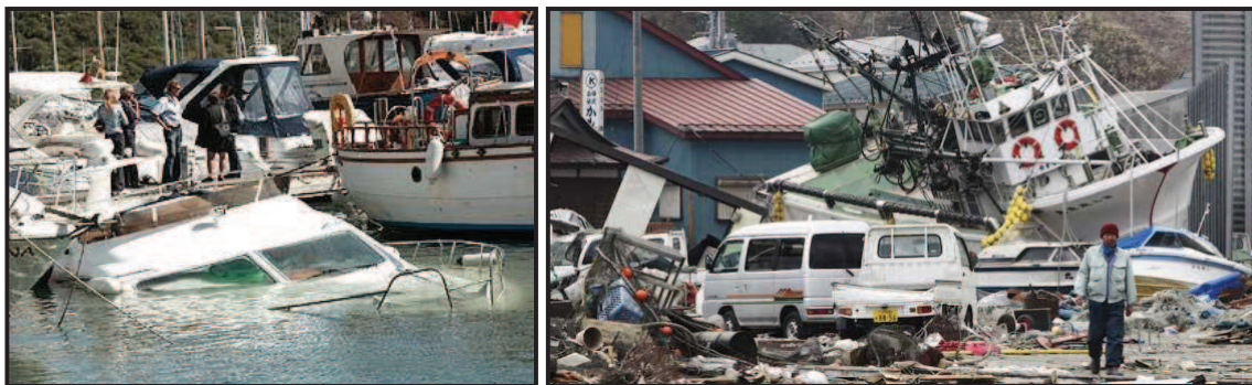
Figura II.5. Daños generados por el rebase del oleaje extremo al rompeolas
