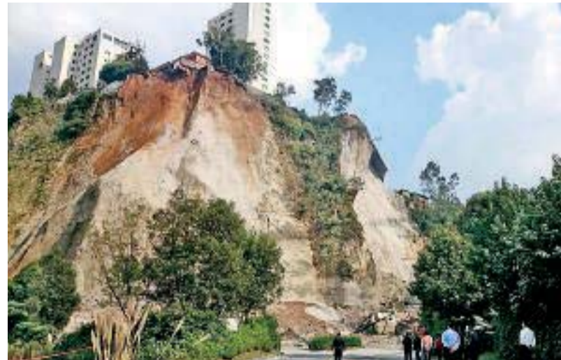
Ante los deslaves registrados, Protección Civil capitalina ordenó desalojar tres de las cinco torres del Fraccionamiento Residencial Vista del Campo.
