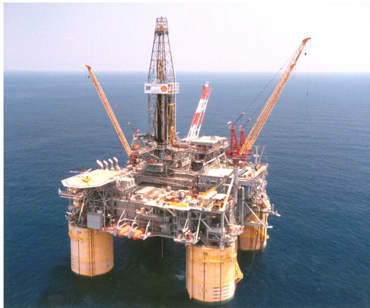
Figura 1. 1 Plataforma de Piernas Tensionadas ubicada en el Norte del Golfo de México.
